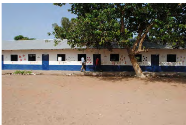
Fig. 3. Les aules amb les teulades noves
