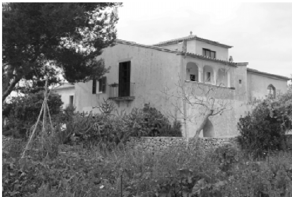
2. Cases de la possessió Sa Galera Nova (a Cas Concos, Felanitx), on s'ubica la Sala del Rei.
