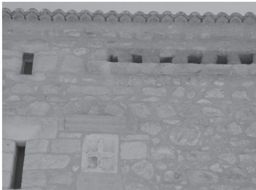
Fig. 5. Detall de la torre del segle XVI que dóna nom a la pedania jumellana de la Torre del Rico.
